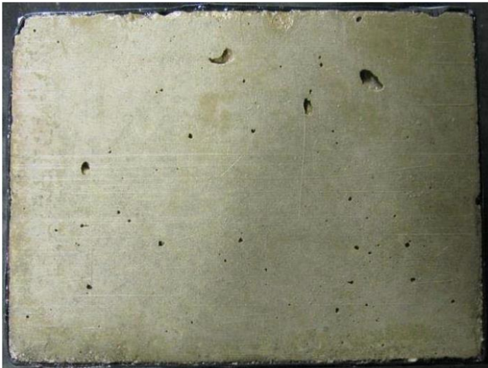
Abbildung 4: Oberfläche des Betons der Serie XD3 nach 28 Frost-Tau-Wechseln. Taumittel Ice & Dust-Away 25 (Originallösung) (Untersuchungsbericht Frost-Taumittel-Prüfung, Universität Duisburg-Essen, Institut für Materialwissenschaft, 2015)
